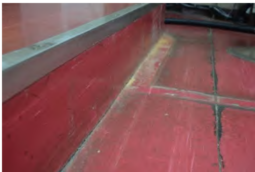
地板變形、龜裂。地科院提供
