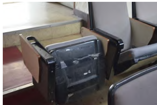
座椅損毀。地科院提供
